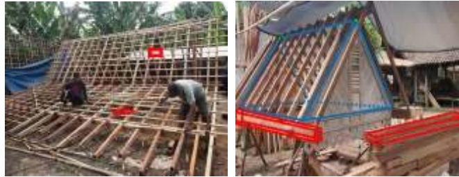
Gambar 2. 18 Bentuk-bentuk Geometris pada Kerangka Atap Rumah Using (dokumentasi)
