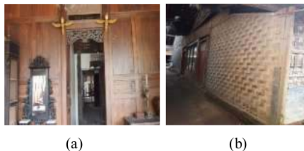
Gambar 2. 8 (a) Gebyug Sebagai Dinding Depan Rumah Using , (b) Gedhek Sebagai Dinding Samping Rumah Using (dokumentasi)
