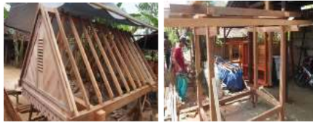
Gambar 2. 4 Konstruksi Rumah Using Berukuran Kecil (dokumentasi)
