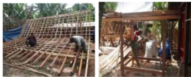
Gambar 2. 5 (a) Konstruksi Atap Rumah Using , (b) Konstruksi Rangka Rumah Using (dokumentasi)
