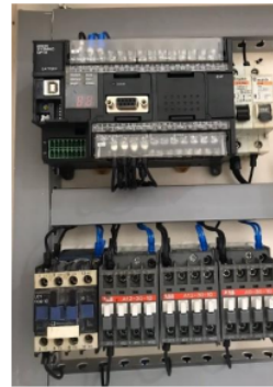
Gambar 3. Wiring Input dan Output Plc
