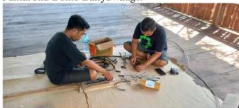
Gambar 4 Instalasi Kabel PLTS dan PLTB.
