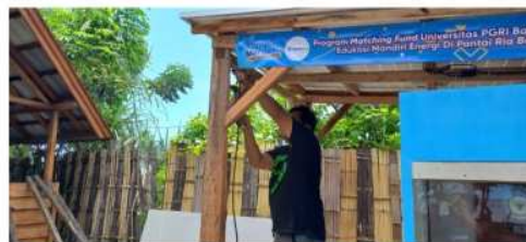
Gambar 6. Instalasi Kabel PLTS dan PLTB
