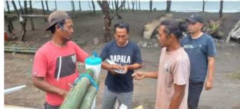
Gambar 5 Keterlibatan Mitra Pada Pendampingan Instalasi PLTS dan PLTB.
