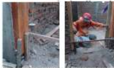
Gambar 5. Lot dan Selang yang Digunakan Tukang Bangunan
