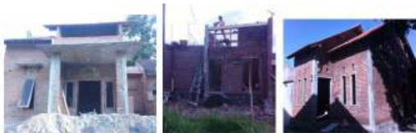
Gambar 4. Tampilan Fisik Bangunan A, B dan C
